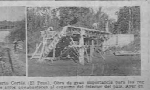
La información gráfica muestra varias vistas de la construcción del muelle en puerto Cortés (El Peño). Obra de gran importancia para las relaciones del sur ya que por ese lugar se realiza el envío de abastecimientos de arroz que abastece al consumo del interior del país. Ayer en la mañana el ingeniero don Max Effinger, visitó los trabajos que ya se encuentran próximos a terminarse.
